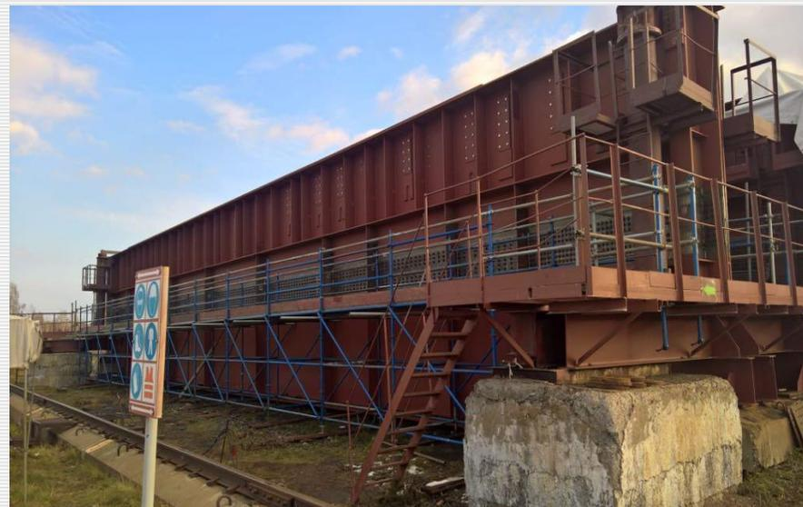
Хребтовые балки высотой 3,5м. и длиной 33м.
