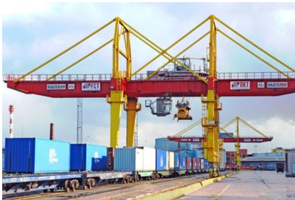
Козловой контейнерный кран грузоподъемностью 45 тонн ОАО «РЖД»
