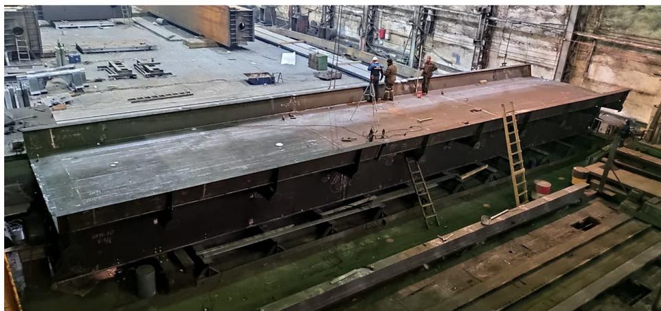
Контрольная сборка мостового пролетного строения - 23 метра (53 тонны)
